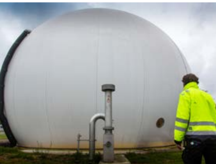
De grotere gasproductie maakte het nodig een nieuwe gasballonhouder van 1.850 kubieke meter te plaatsen
