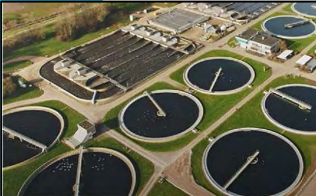
De rioolwaterzuiveringinstallatie Oijen stamt uit 1975 | foto: Waterschap Aa en Maas
